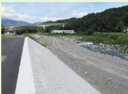
小黒川（護岸整備）
