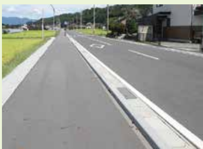
県道車屋大久保線（拡幅改良）
