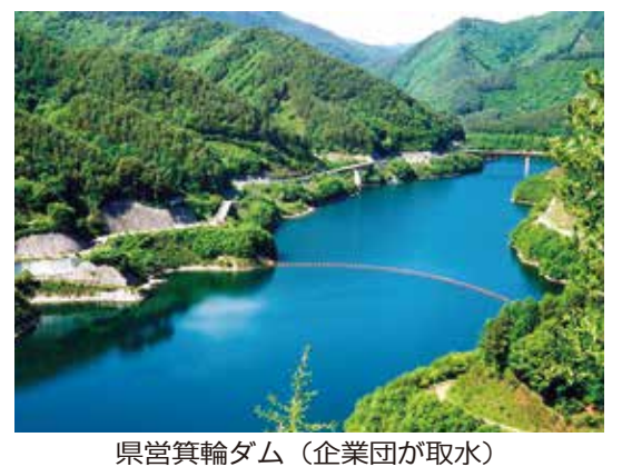
県営箕輪ダム (企業団が取水)
