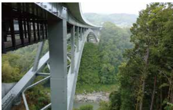
三遠南信自動車道 天竜峡大橋
