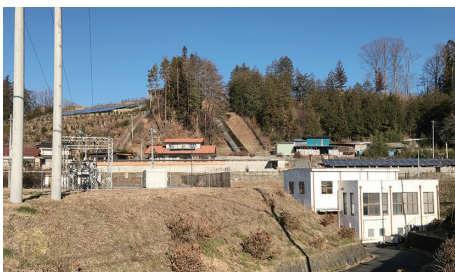
水路の老朽化が深刻な西天竜発電所(小沢)
