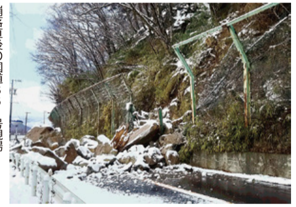
崩落直後の国道361号現場
